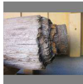
Teuchelrohrende mit eingeschlagener Metallhülse, die als dichter Übergang zur nächsten Teuchel benötigt wurde.
