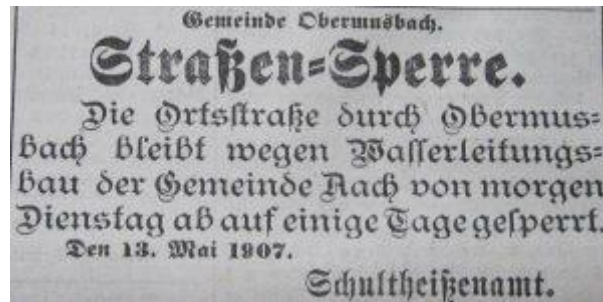
Straßensperrung in Obermusbach 1907
