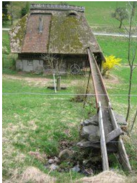
Beispiel Wasserzuführung zur Mühle am Hang
