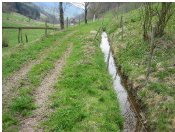
Beispiel eines Zuführungskanal zur Mahlmühle
